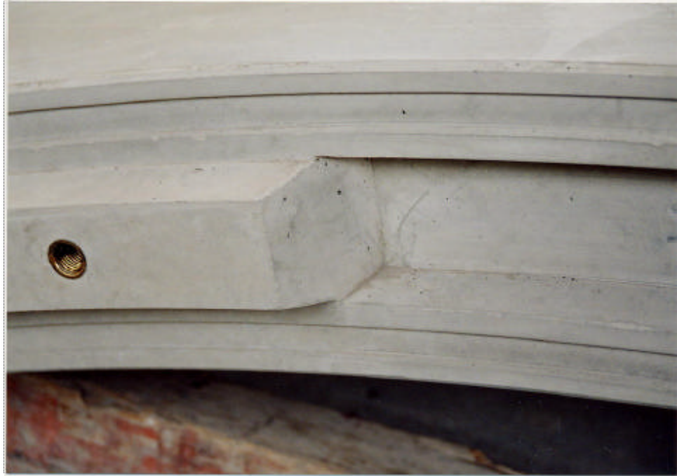
写真 - 2 3 リング載荷実験供試体（ロック部）
