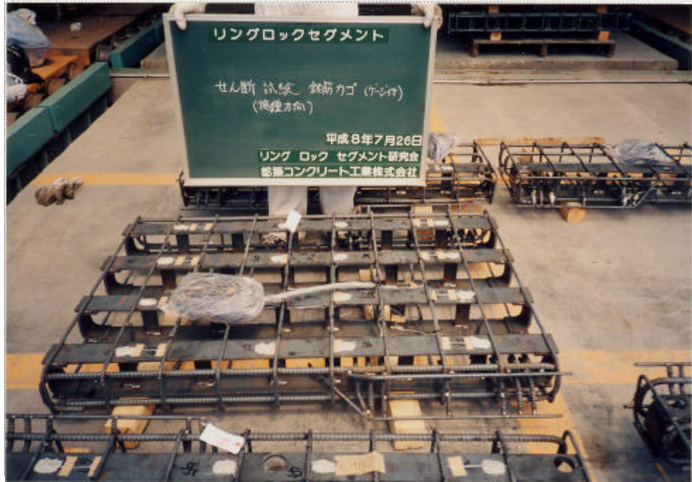
写真 - 9 継手せん断実験供試体鉄筋籠 (接線方向 : ゲージ貼付)
