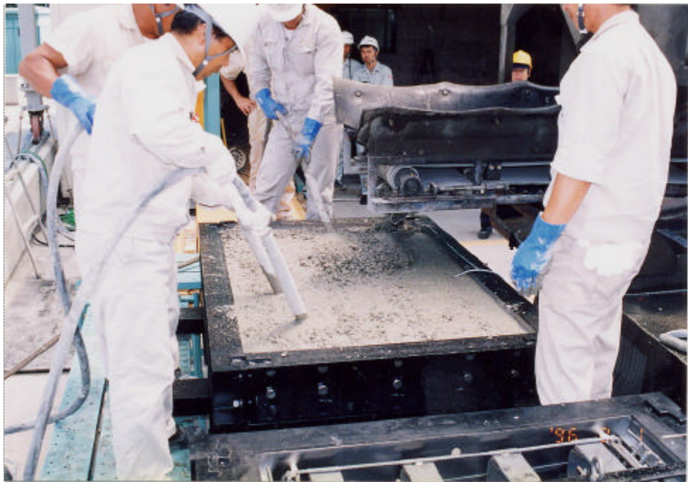
写真 - 2 継手曲げ実験供試体打設状況
