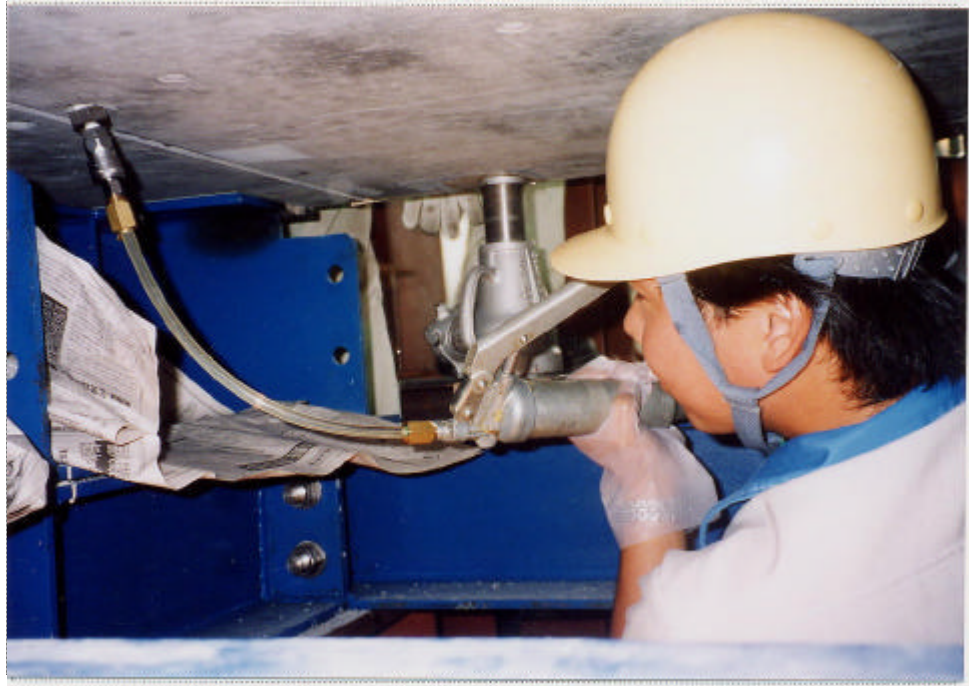
写真 - 17 継手せん断実験工ポキシ注入状況（接線方向）
