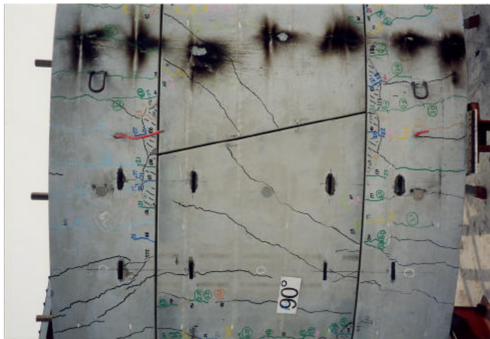
写真 - 30 リング載荷実験ひびわれ状況5 (外面: 90度付近)
