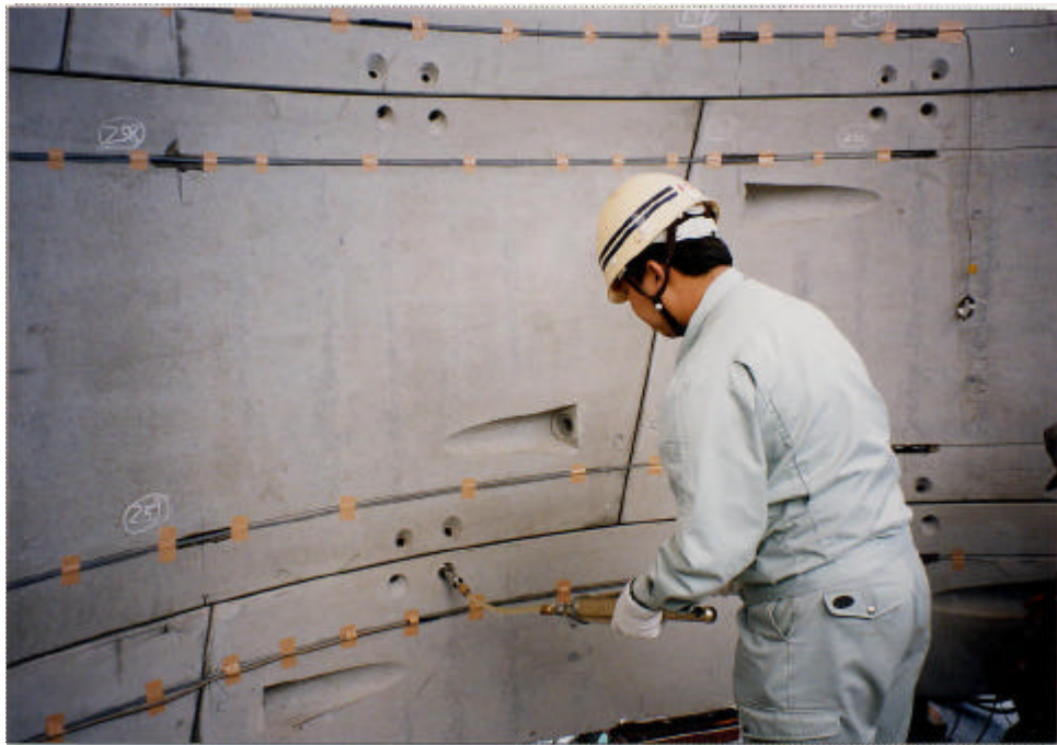
写真 - 2 4 リング載荷実験エポキシ注入状況
