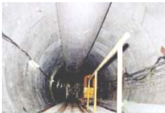
内面平滑な施工例(コネクタ+貫通ボルト)
