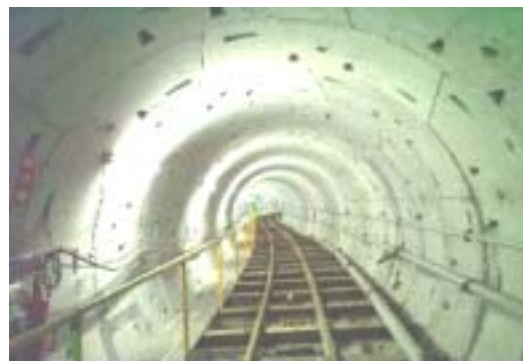
斜めボルトを用いた施工例
